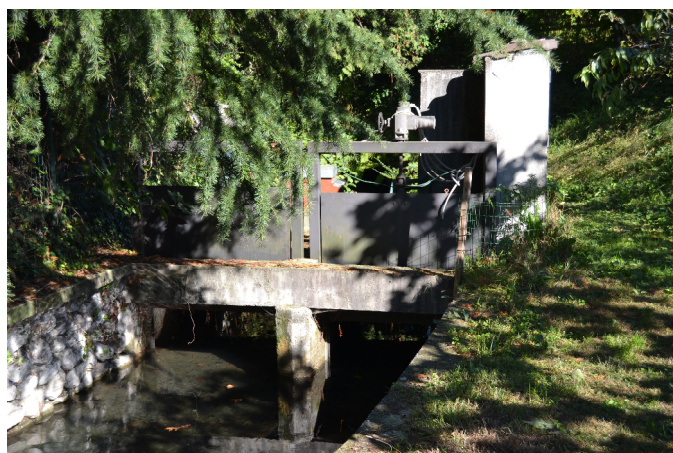
Figura 5.2: Paratie localizzate in prossimità dei punti di misura del livello
